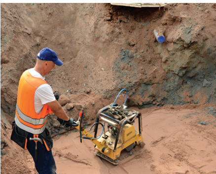
Jämna ut och komprimera ihop botten på montageschaktet med omsorg.
