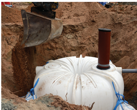
Fyll schaktet försiktigt med installationssand.
