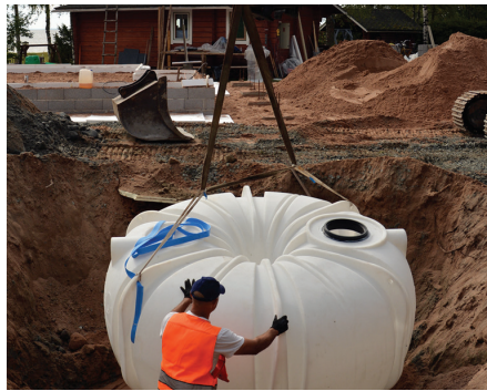
Tanken lyfts med hjälp av lyftöron och -linor.
