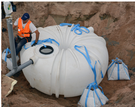
Förankra den slutna tanken från åtminstone fyra håll.
