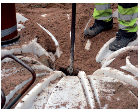
Blöt ner hålet som finns i mitten på den slutna tanken i samband med igenfyllningen.
