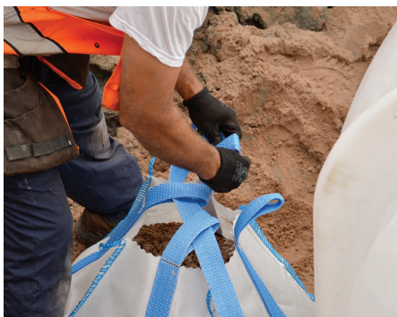
Trä igenom förankringslinan genom de utplacerade och fyllda förankringspåsarnas öglor.
