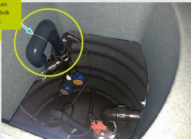
Bild 5: Montering av S-krök.
